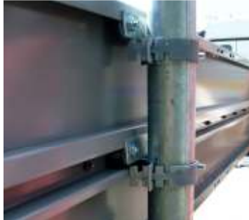
Uchwyt typu „Zacisk” zamocowany do tablicy – widok od strony ząbka
