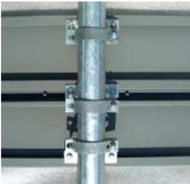
Tablica zamocowana do supka za pomocą uchwytu typu „Zacisk”
