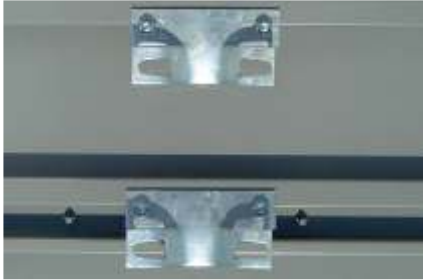
Uchwyt typu „Zacisk” zamocowany do profilu
