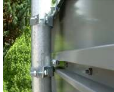
Uchwyt typu „Zacisk” zamocowany do tablicy – widok od strony śruby
