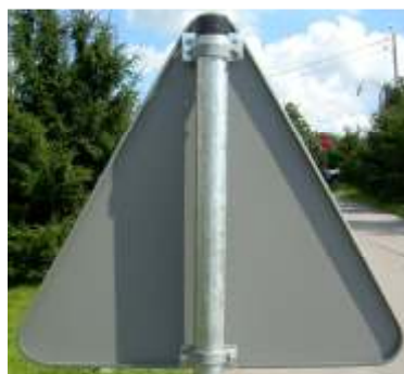
Uchwyt typu „Zacisk” zamocowany do krawędzi znaku
