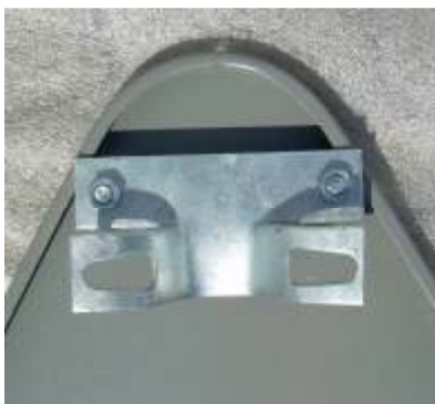
Uchwyt typu „Zacisk” zamocowany do znaku trójkątnego
