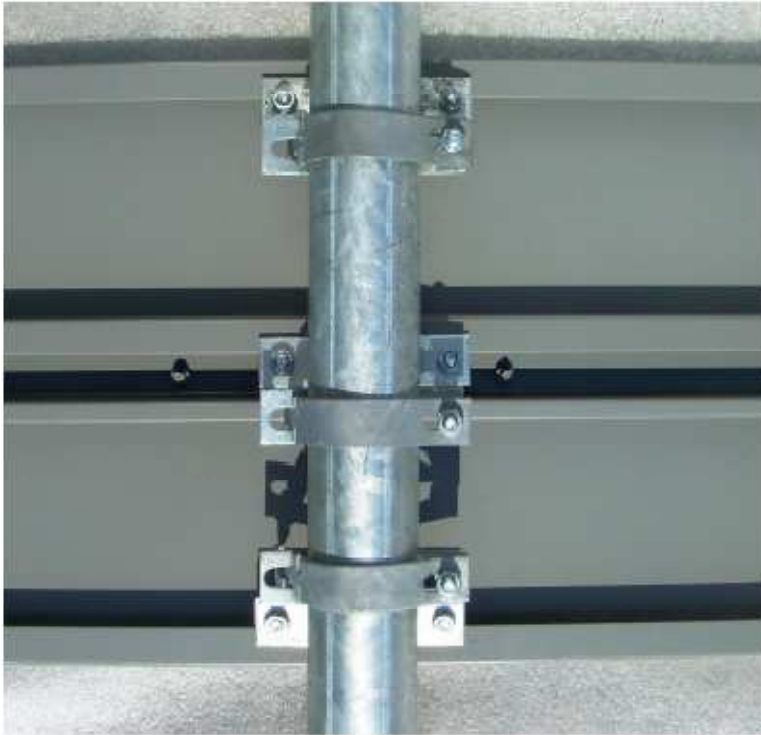
fot. 5 Tablica zamocowana do słupka za pomocą uchwyty typu „zacisk”
