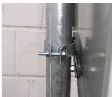
fot. 3 Uchwyt typu „zacisk” – widok od strony śruby
